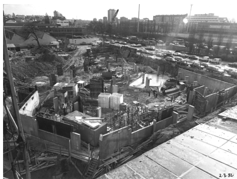
Travaux de construction au 2 mars 1982, © Marcel Delius, Fonds UFM
